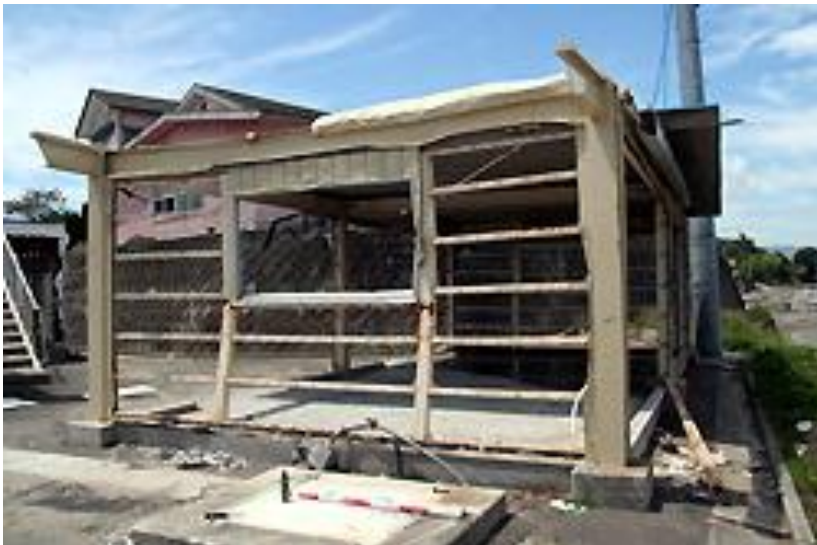
津波被害を受けたPCB保管庫(福島県)
